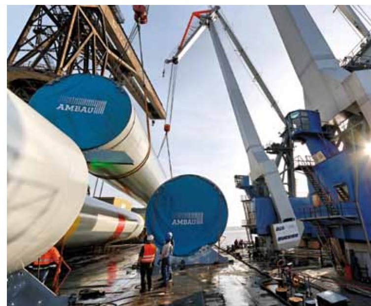
Verladung von Offshore-Turmsegmenten
