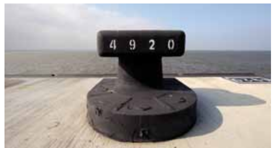
Die Stromkaje des Containerterminals Bremerhaven – mit 4.920 Metern die längste Stromkaje der Welt
